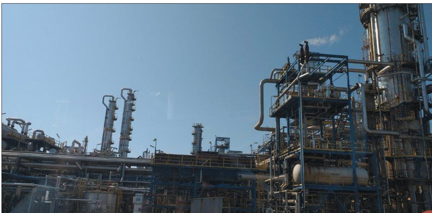
Rysunek 4. Fotografia instalacji technologicznej w rafinerii Figure 4. Photo of a technological installation in a refinery
