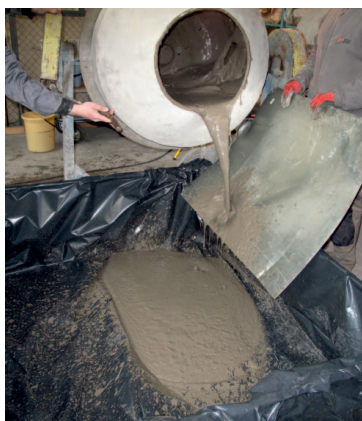
Rys. 7. Mieszanka przygotowywana do zestalania
